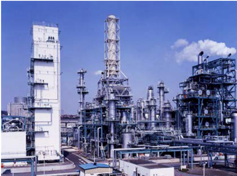
Figura 6 – Impianto di gassificazione di asfalti residui di raffineria, NEGISHI, Giappone (2003)
